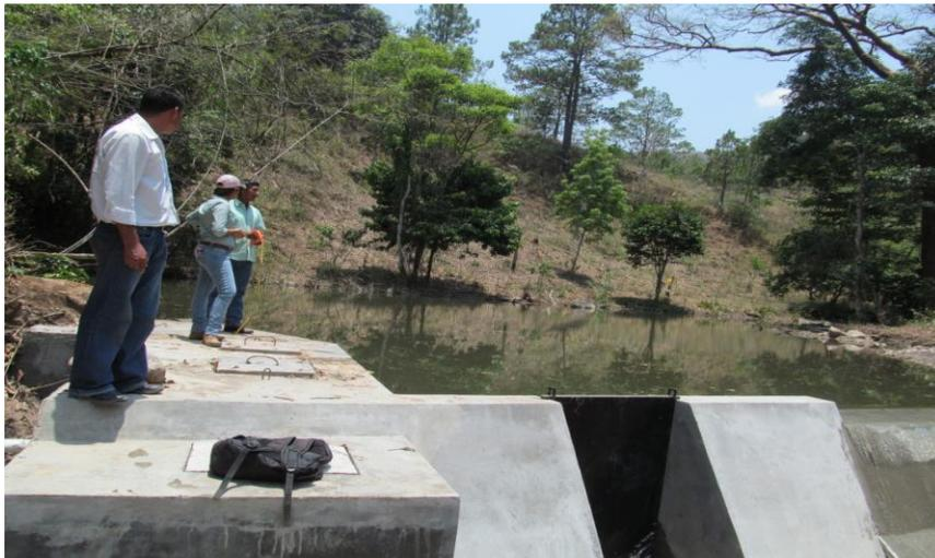
**Línea de Conducción.** La línea de conducción está construida con tubería HG en la salida de la obra de toma del agua y de PVC en el resto del recorrido, el diámetro varía entre 8", 6" y 4" hasta llegar al tanque de distribución. La distancia aproximada es de 7 km desde la obra de toma hasta el tanque el Rubí.
