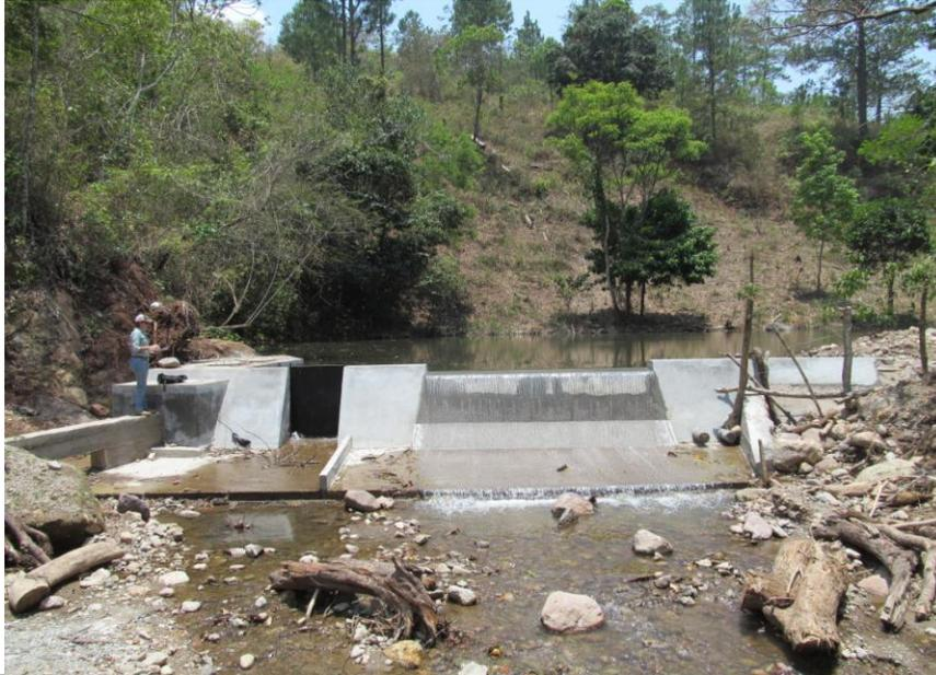
Obra de toma de la fuente el Escondido, con sus cajas colectoras laterales
