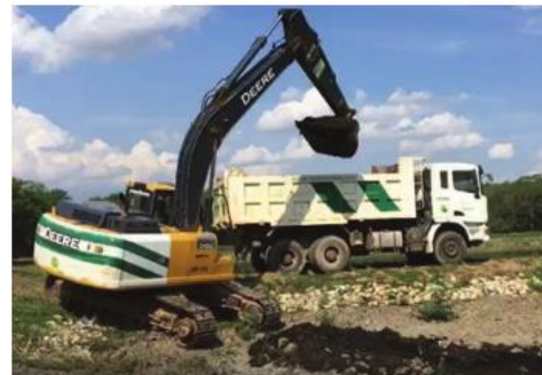
Fotografía 27: Extracción de lodos a volqueta.
