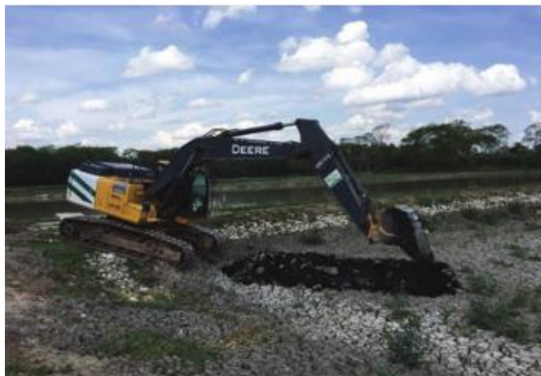
Fotografía 26: Extracción de lodos utilizando una retroexcavadora.
