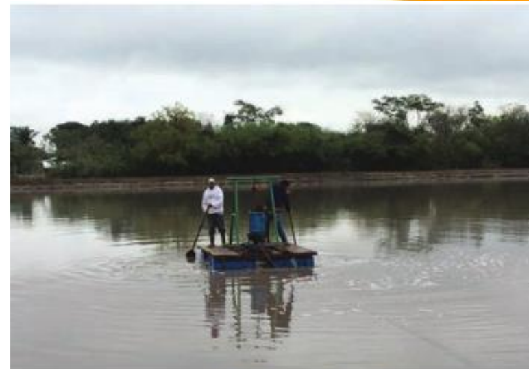
Fotografía 25: Desagote de laguna.
