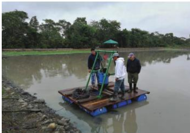
Fotografía 24: Ingreso de bomba a laguna para su desagote.
