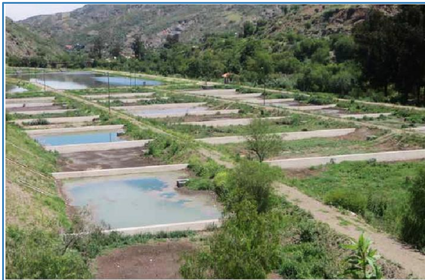
FIGURA 26: LECHOS DE SECADO, PTAR SUCRE
