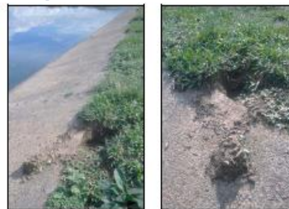
Fotos 7-11: Las tortugas pueden excavar atrás y abajo del revestimiento para depositar sus huevos. El operador debe monitorear la condición del revestimiento de rutina cuando hay poblaciones altas de tortugas. (Danli, Honduras)
