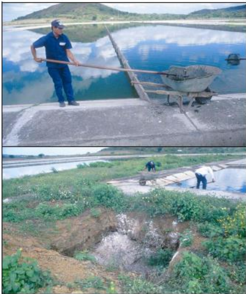
Fotos 7-6: Las natas y sólidos flotantes se acumulan en las esquinas de las lagunas, donde el operador puede sacarlos fácilmente con un desnatador y ponerlos en una carretilla. Después, se debe enterrarlos, o cubrirlos con una capa de suelo o cal. En la foto abajo los operadores ponen las natas recolectadas en un pozo y los cubren con cal para controlar olores. Cuando se llena la excavación se cubre con una capa de suelo. (Masaya, Nicaragua)
