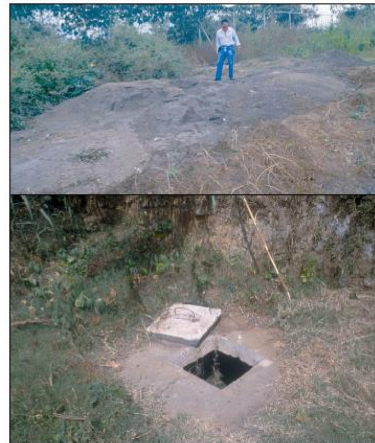
Fotos 3-14: Los sólidos arenosos siempre estarán contaminados con patógenos y su disposición final requiere una solución sanitaria para proteger la salud de los operadores. En la foto arriba (León, Nicaragua) la pila de sólidos arenosos debería de haber enterrada; nótese también la cantidad de material producido que hubiera entrado una laguna primaria sin el desarenador. Una solución adecuada mostrada en la foto abajo (Urbanización en la Ciudad de Guatemala) es una fosa séptica construida específicamente para la disposición final de los sólidos arenosos.
