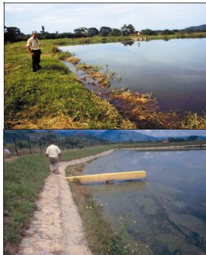
Fotos 6-18: En la foto arriba (Tela, Honduras) la laguna facultativa tiene problemas con el crecimiento de hierbas acuáticas en la orilla por falta de un revestimiento. En la foto abajo (Catacamas, Honduras) la deficiente construcción del revestimiento (notase las curvas de nivel) con insuficiente borde libre no previene el crecimiento de plantas acuáticas en la orilla.
