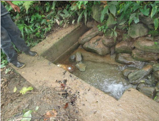
Vista general caja toma
