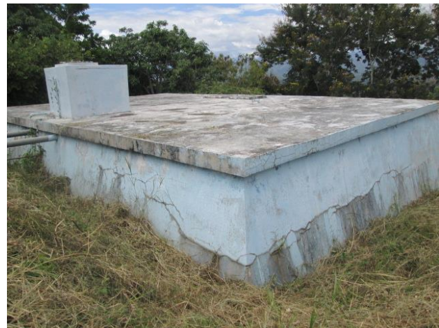
Tanque trapezoidal de dos cámaras
