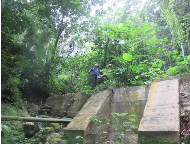
Vista general Presa
