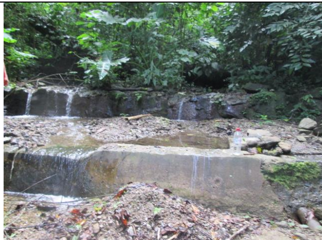
Obra de toma y caja de captación lateral
