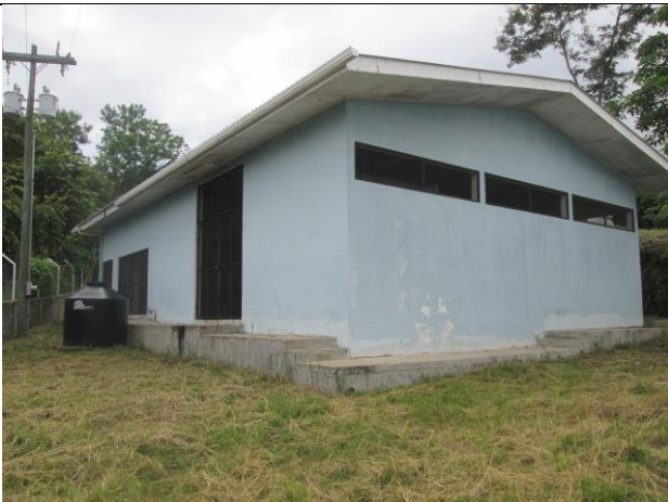
Vista general edificio de planta potabilizadora
