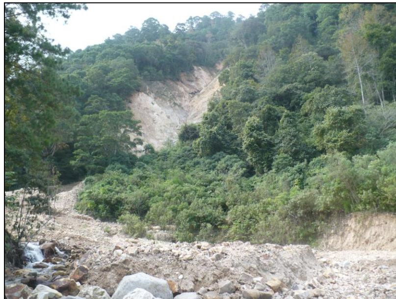
Derrumbes En zona aledaña a La Cascada
