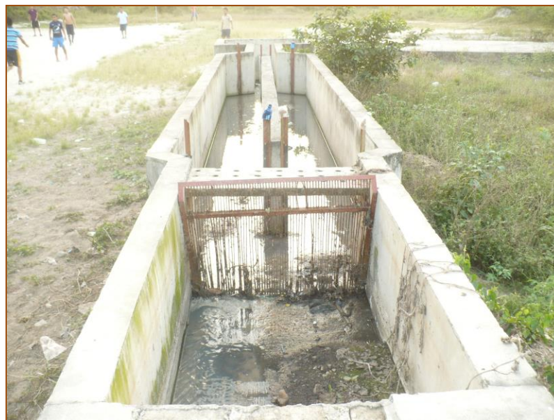
Obras de Planta de tratamiento del casco urbano
