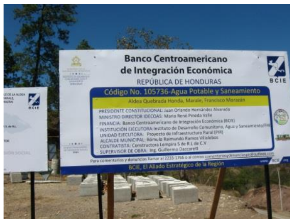
Fotografías de la visita al proyecto de agua potable y saneamiento, en Quebrada Honda
