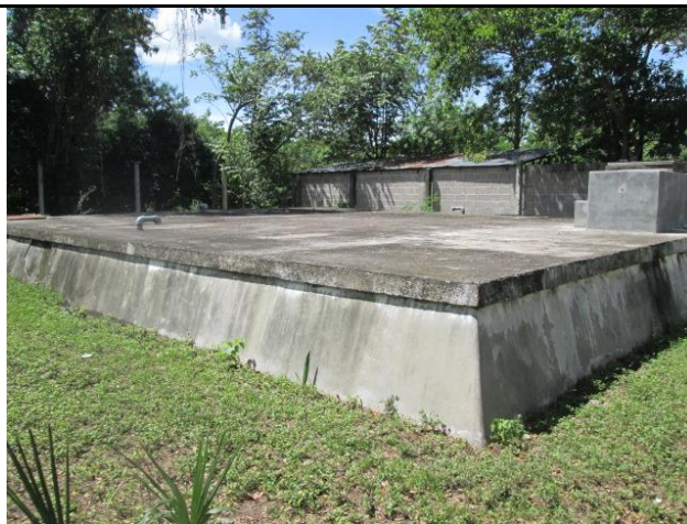
Losa y paredes del tanque
