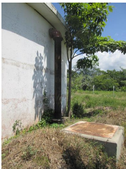
Vista tubería de rebose
