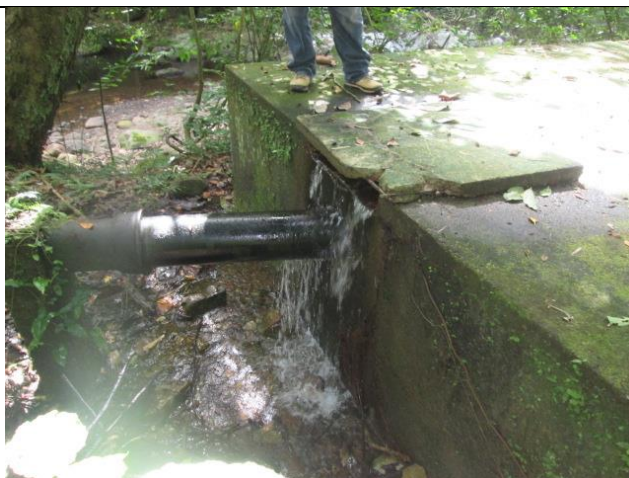
Entrada y rebose de desarenador línea presa Pimienta aguas arriba
