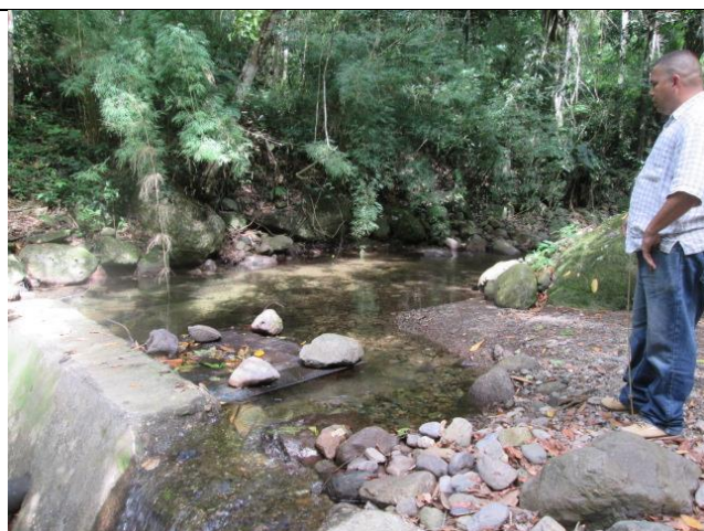
Vista general obra de captación
