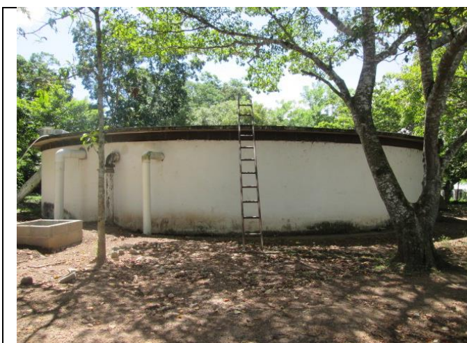
Vista general del tanque (entradas)
