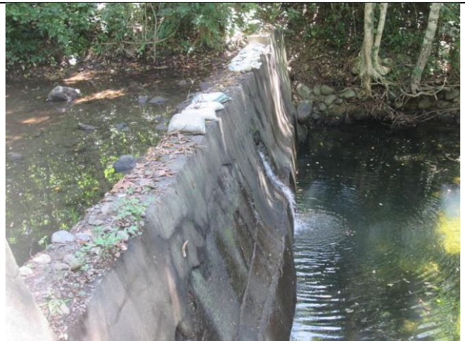
Vista frontal de la captación
