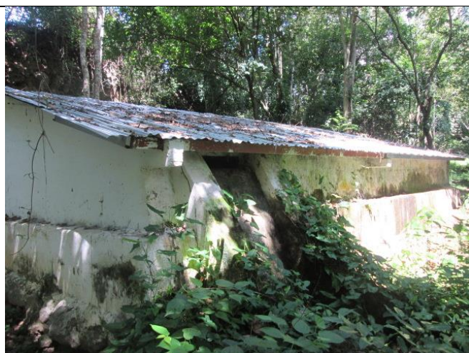
Desarenador presa vieja pimienta a tanque Agalteca cuadrado
