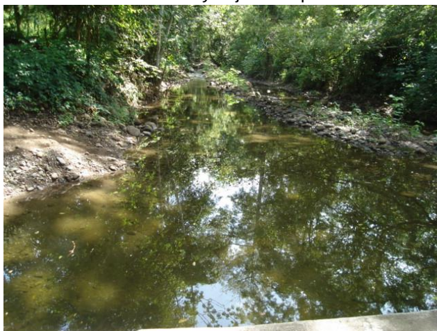
Vista aguas arriba de la obra de toma
