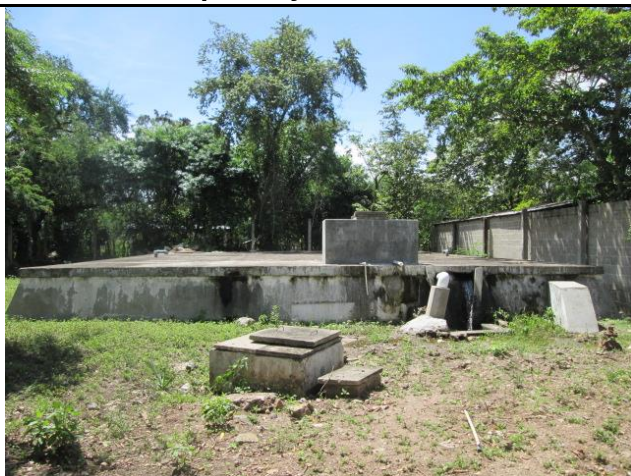
Vista general del tanque y rebose
