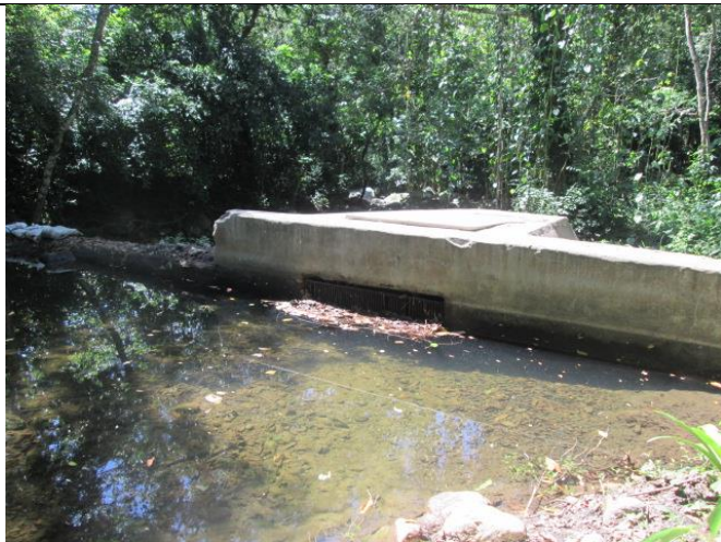
Obra de toma y caja de captación
