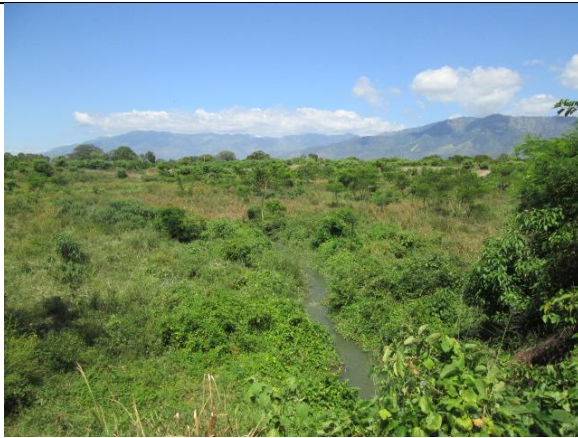
Caudal de aguas negras que sale de la laguna No. 1 atraviesa la laguna No. 2 sin ningún tratamiento. (vista hacia el noroeste)
