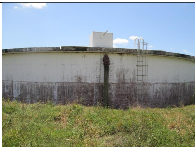
Vista general del tanque
