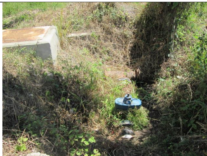
válvula de salida sin caja
