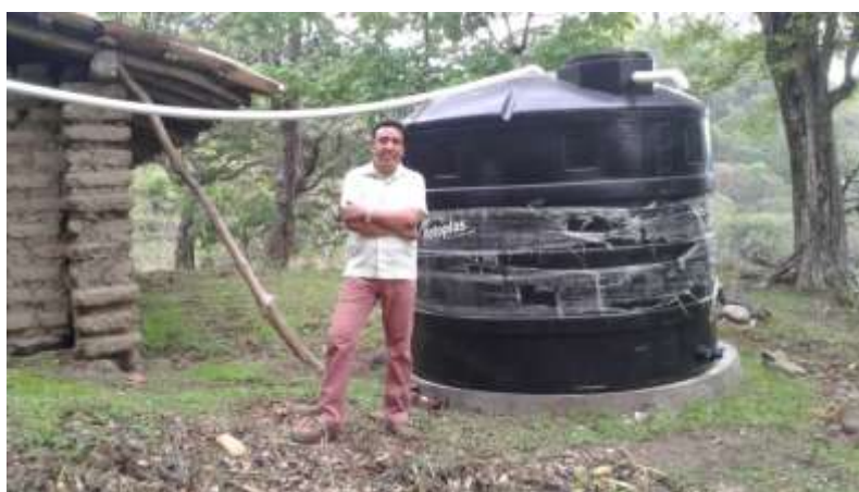
Recientemente se instalaron tanques para la captación de aguas lluvias en la comunidad de Santa Rita.
