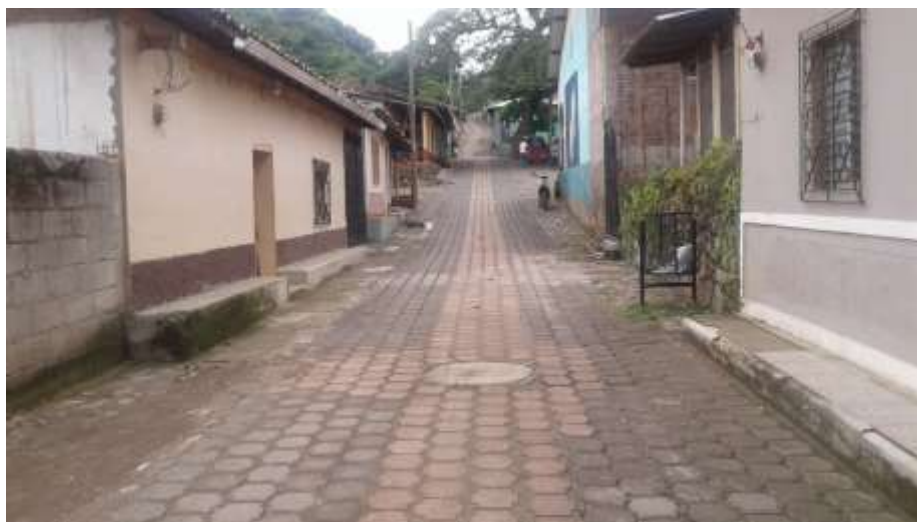
Pozo de inspección de alcantarillado sanitario en Santa Lucía, Intibucá
