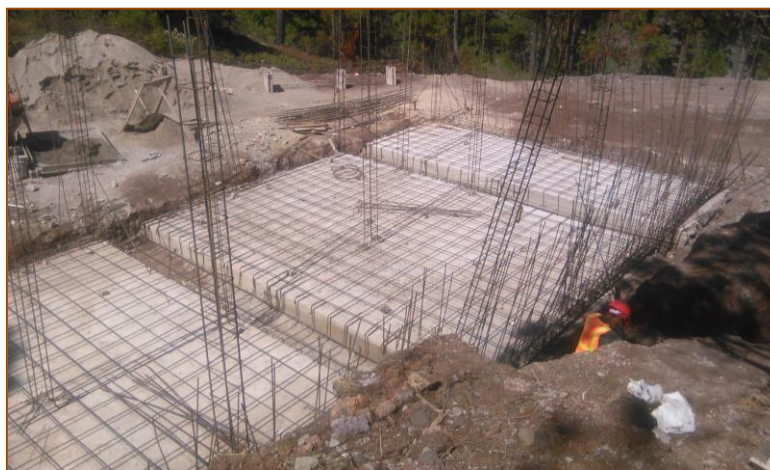
Obras en ejecución del Proyecto de Alcantarillado Sanitario, casco urbano
