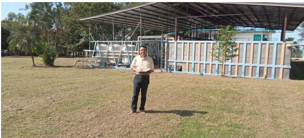
Laboratorio y planta de tratamiento de agua del SANAA
