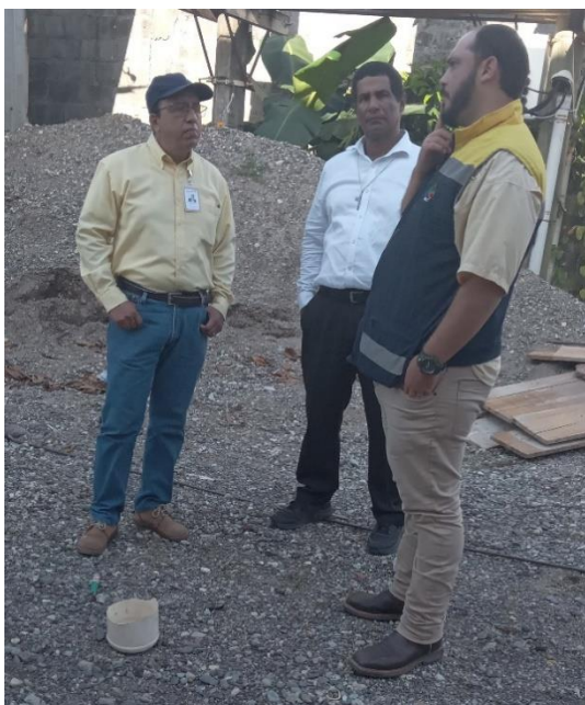
Visita a Estación elevadora de aguas residuales, acompañó Ing. Harold gerente de OMASAN y Lic Fuentes encargado de la UMA.
